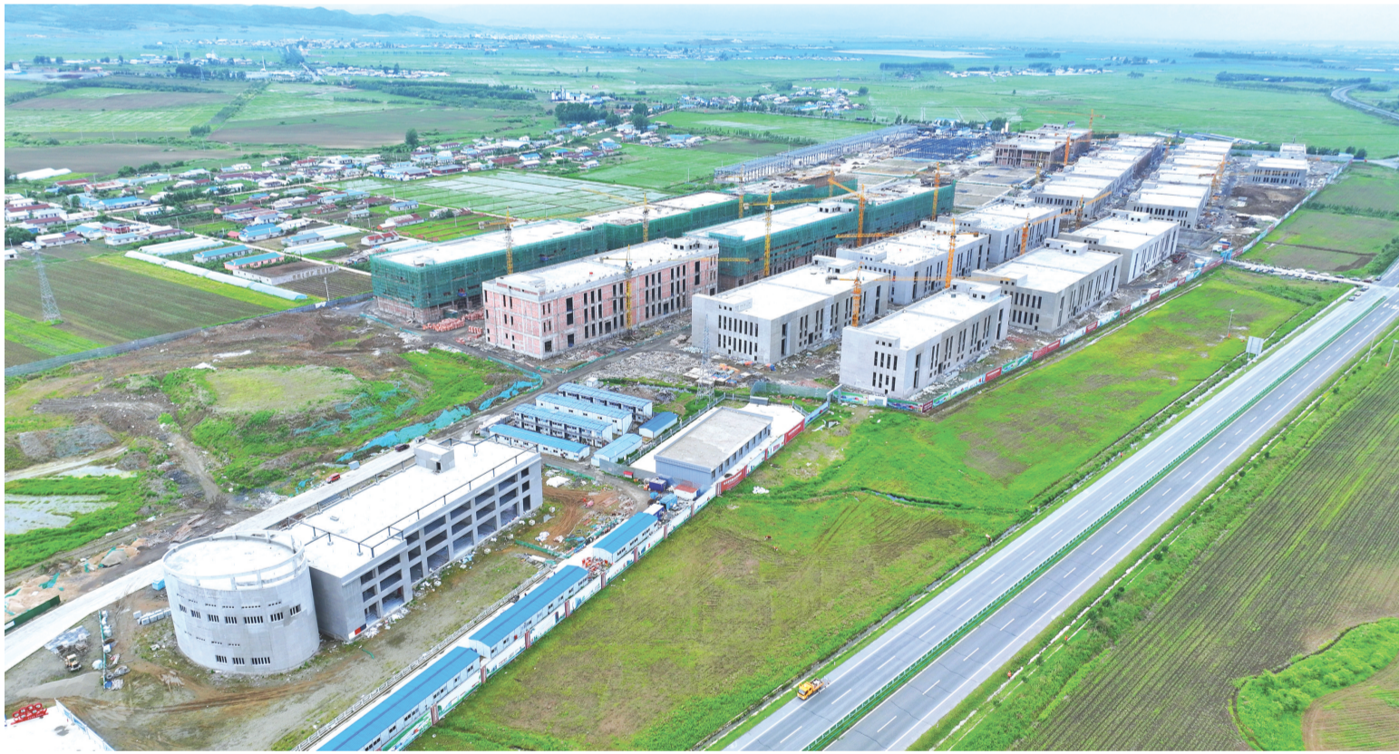
图为珲春铁路国际物流园区项目建设现场鸟瞰。 本报记者 郎鹏 摄
