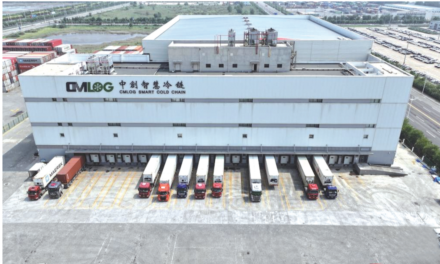
在天津东疆综合保税区中创智慧冷链有限公司,冷链运输车在冷冻库旁装卸货物(7月3日摄,无人机照片)。
