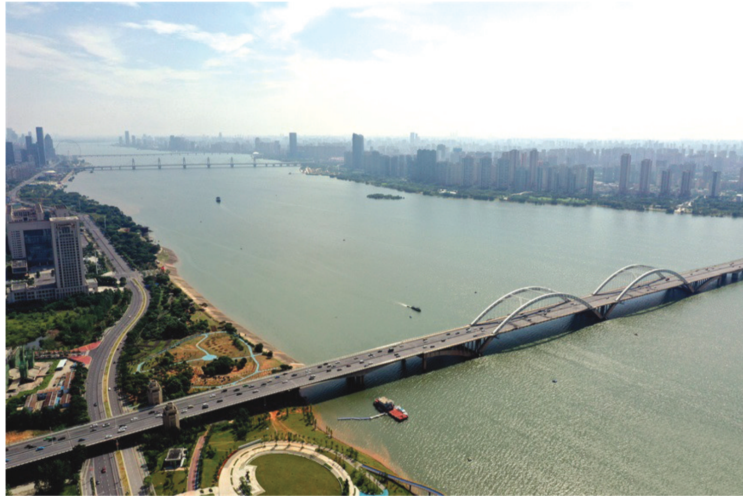
7月13日,在江西省南昌市红谷滩区的赣江区域上空看到,新建成通车的洪州大桥、复兴大桥以及更远处的生米大桥、南昌大桥等桥梁尽收眼底,一座座跨江通道连接赣江两岸,撑起城市空间拓展。近年来,南昌市有序推进“十桥同架”建设项目,目前有八座正在建设,其中,复兴大桥和洪州大桥已经实现主线建成通车。这些“一江两岸”的大桥,将为南昌“东进、南延、西拓、北融、中兴”城市发展战略提供有力支撑,促进区域经济协调发展。人民网记者 时雨 摄
