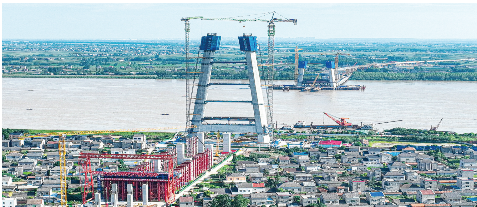
7月18日拍摄的湖北枝江百里洲长江大桥施工现场(无人照照片)。当日,历经9个小时连续浇筑,由四川路桥集团大桥公司承建的湖北枝江百里洲长江大桥,北岸边跨现浇梁首件成功浇筑完成。百里洲是长江枝江段一座大型江心洲,面积约228平方公里,人口近10万人。长期以来,洲上的居民出行只能依靠轮渡。正在建设中的枝江百里洲长江大桥全长1549米,预计2026年建成通车。新华社记者 肖艺九 摄
